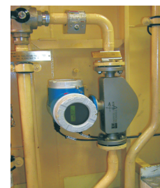
Promass E come "misuratore di carburante" sulla mandata al motore
