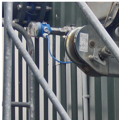
Soglia di livello del fermentatore: Liquicap M
