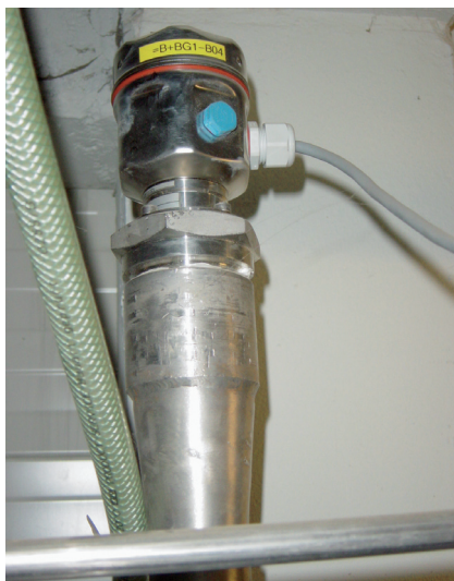
Misura della pressione nella linea del biogas: Cerabar
