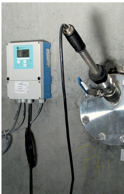
Misura di pH (a sinistra) e misura della materia solida (a destra) con trasmettitore Liquisys, sensori e installazione nel processo
