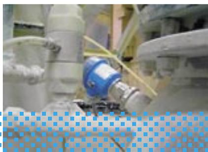
Segnalazione del livello in un serbatoio sotto pressione con **Soliphant T**
