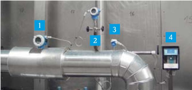
La soluzione completa per la misura di quantità di vapore: portata (1), pressione (2) e sonde di temperatura (3) sono collegati ad un calcolatore di energia (4). Il servizio energy proving di Endress+Hauser include la verifica del loop di misura completo.
