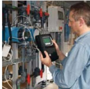
Simulazione e verifica di un misuratore di portata sono eseguite utilizzando il nostro dispositivo Fieldcheck.
