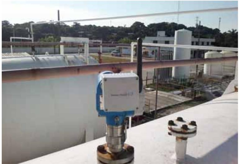
Trasmettitore Levelflex con adattatore WirelessHART su un serbatoio di materie prime grezze a Coatzacoalcos, Messico
