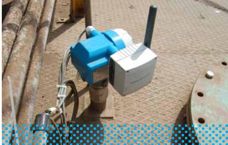
Dispositivo da campo con adattatore WirelessHART installato a distanza in posizione difficilmente accessibile
