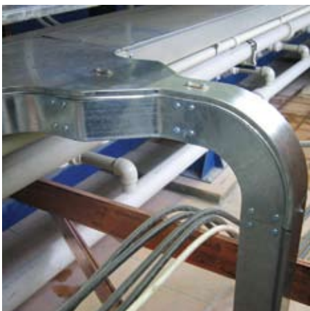
Uscite laterali con riduzione degli elementi.
