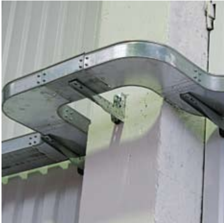
Utilizzo di 4 curve piane 90° per aggirare una colonna.
