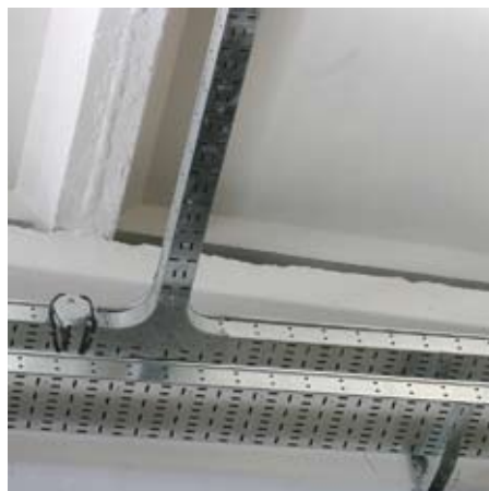
Attacco di cassette di derivazione laterali.
